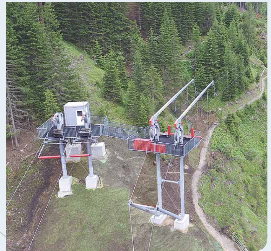
Bei den Zwischenstationen muss die Plattform gewechselt und der Seilroller umgehängt werden. Sobald die Bahn frei ist und das Freizeichen für den Weiterflug gegeben ist, kann der Flug fortgesetzt werden.
